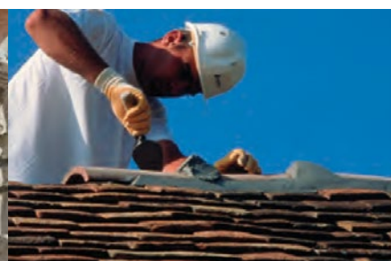
ENDUIT DE TEINTE GRISE
